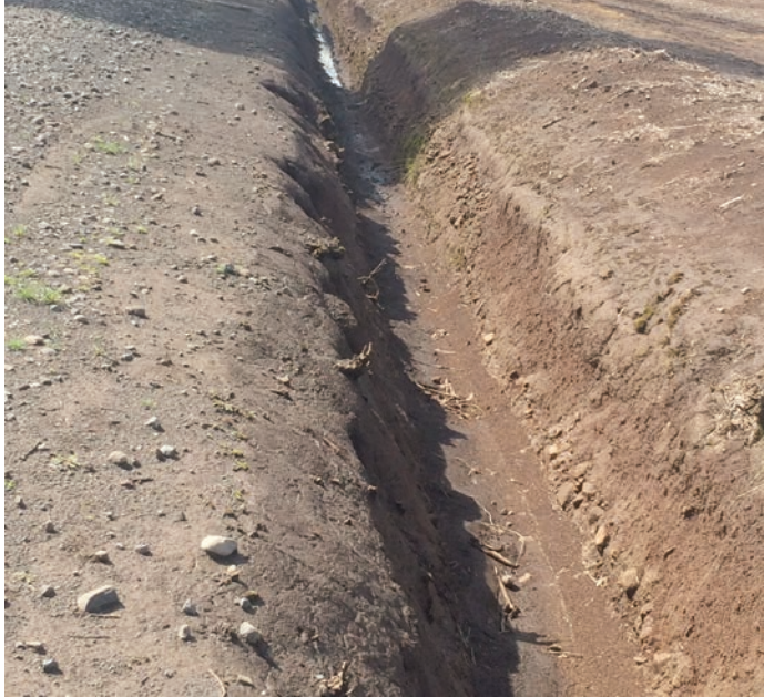
Figura 4.3. Confección de salida de agua en la zona lateral del huerto cuando existen problemas de mal drenaje.
